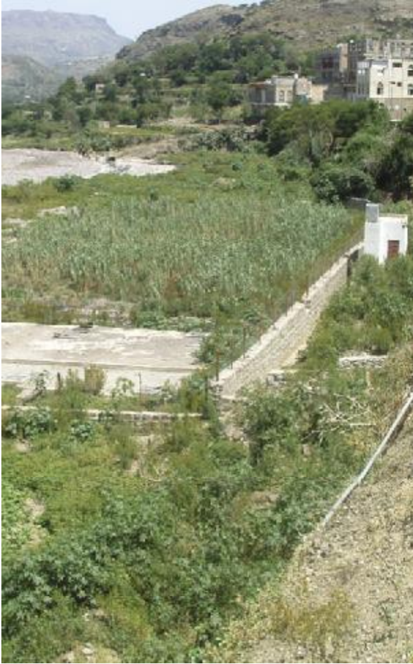
مشروع معالجة مياه الصرف الصحي ( السدة ، إب )
